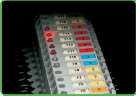
Indicador de fusível queimado por LED ou lâmpada de neon.
