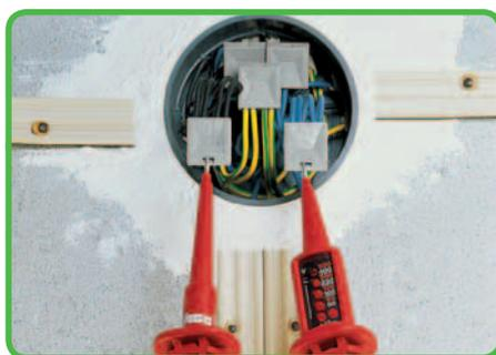
Teste de tensão em conectores PUSH WIRE®.
