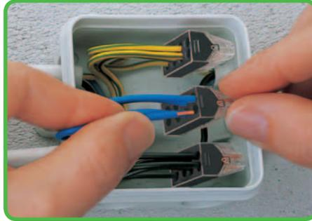
Conexão: insira o condutor sólido totalmente decapado!
