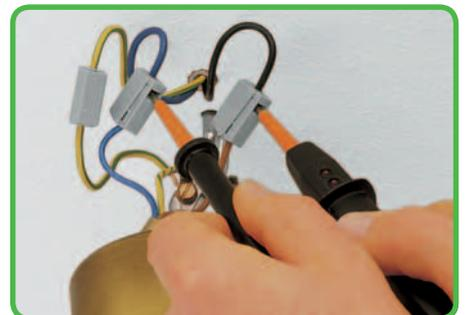
Medição de potencial através da fenda de teste
