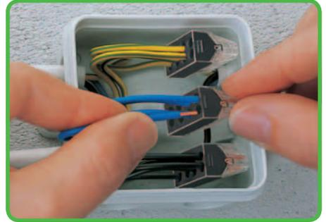
Remoção: segure o condutor a ser removido e gire alternadamente para a esquerda e direita puxando o condutor.
