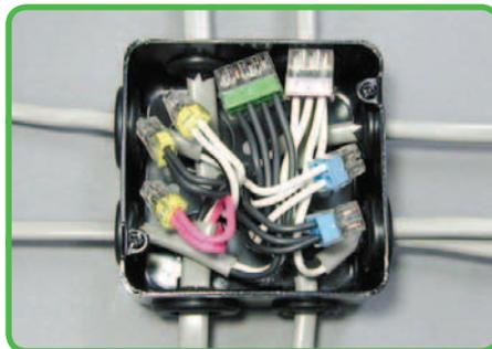
Conectores PUSH WIRE® usados em uma caixa de distribuição.
